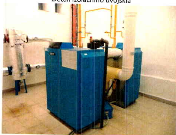
Zdroj tepla – plynová kotelná
